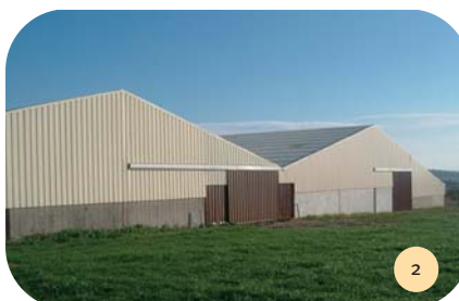
Vue extérieure du bâtiment.
