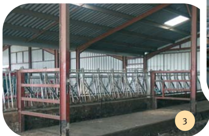
Séparations sur la stalle d'alimentation au niveau de chaque travée.
